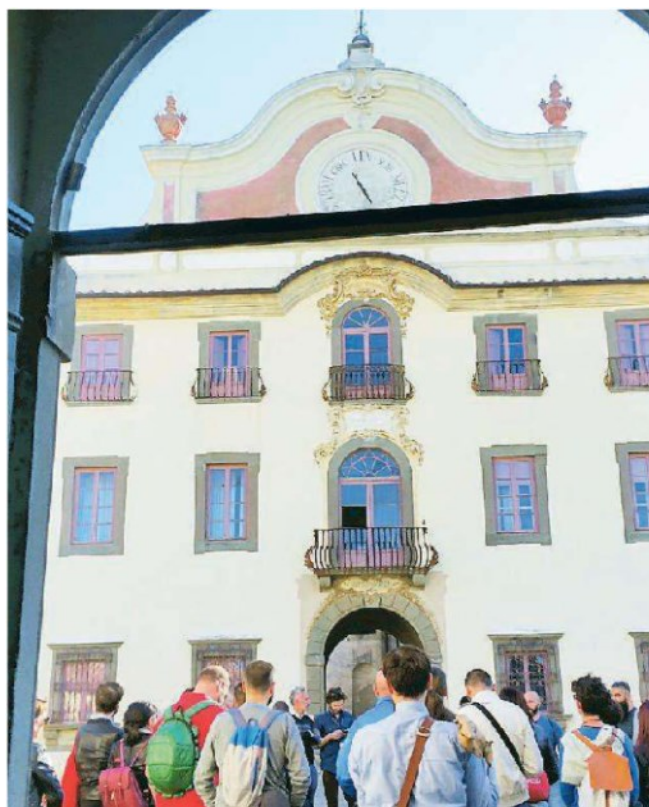
L'ingresso della Certosa monumentale di Calci
